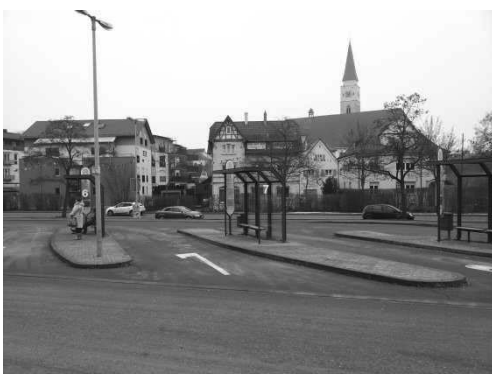
■ Abbildung 12: Ehingen Busbahnhof
